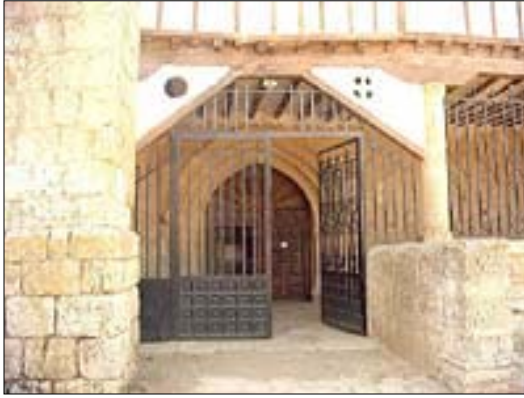
Atrio y pórtico de acceso
